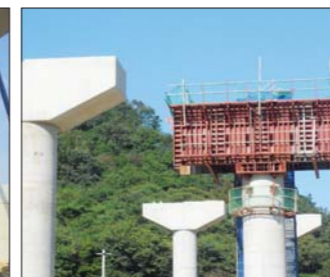
청양~우성간 도로공사 제2공구
