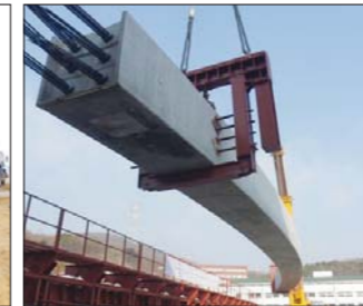
Curved Box Girder 인양
