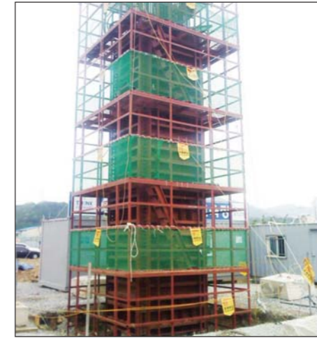
대구도시철도 3호선 1공구
