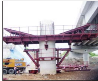
Coping 바닥폼 및 Truss 설치
