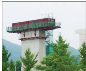
장항선 복선전철 제5공구
