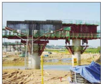
철근작업 및 콘크리트 타설
