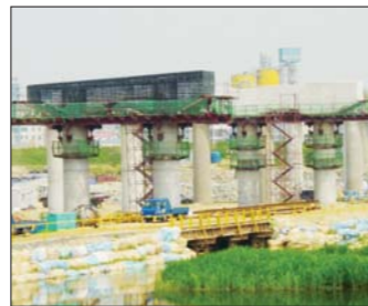
철근작업 및 콘크리트 양생
