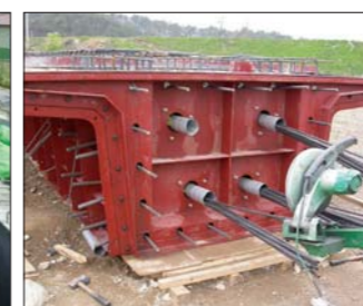
WPC Girder 강선삽입
