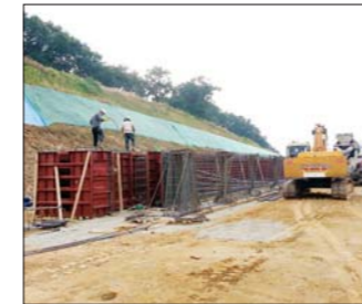
B.I.B girder 콘크리트타설
