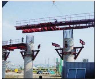
Coping Truss 설치
