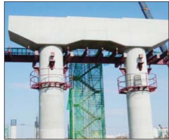
Coping Truss 해체
