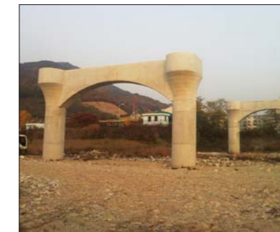
중앙선 전동차 사무소 건설공사
