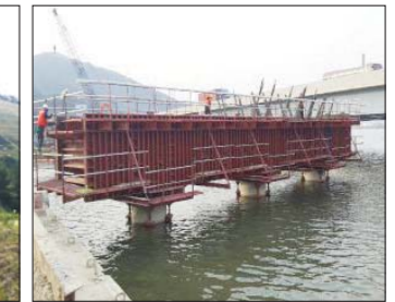
냉정~부산간 확장공사 제3공구
