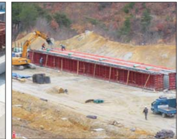
Dr. Girder 콘크리트타설
