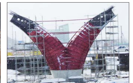
평동산단 진입도로 제3공구
