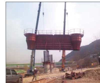
Coping Form 설치
