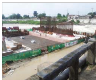
원평천 해창갑문 설치공사
