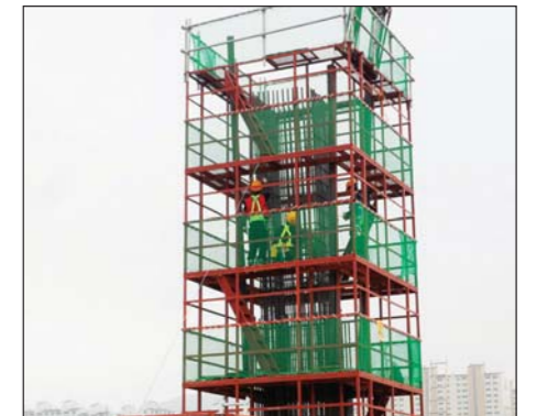
대구도시철도 3호선 3공구
