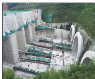
임하댐 비상여수로 건설공사
