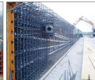
IPC Girder 강가로보조립
