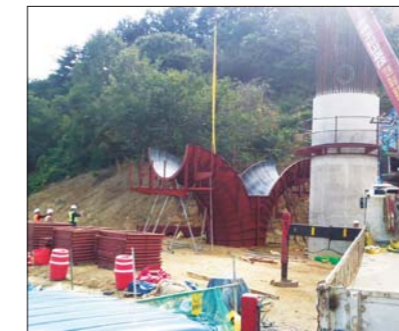
진주~광양 복선전철 제6공구
