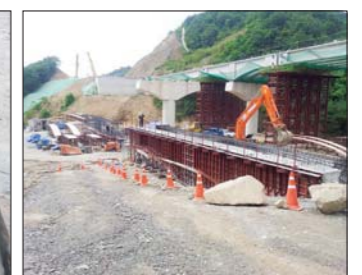
Spliced Girder 제작 및 가설
